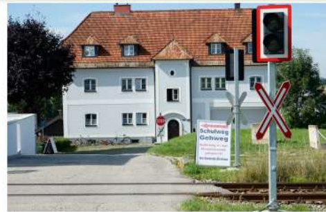
Die Hinweisschilder der Gemeinde zeigen die Sperre des Gehsteigs.
